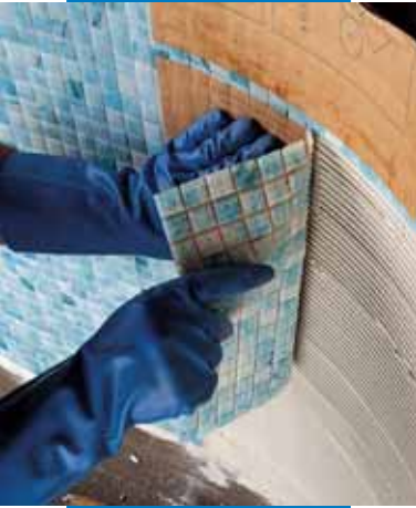
Polaganje staklenog mozaika 2x2 cm u plivačkom bazenu Adesilex -om P10 pomiješanim s Isolastic -om razrijeđenim 1:1
