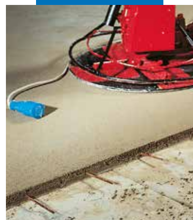
Strojno zaglađivanje površine Topcem-a
