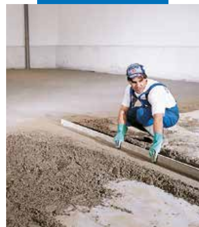
Priprema vodilica za visinu
