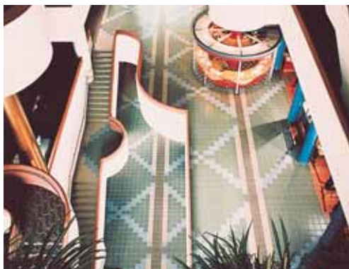
Porculanizirani gres položen s Kerabond+Isolastic - Gradski centar North York Ontario (Kanada)
