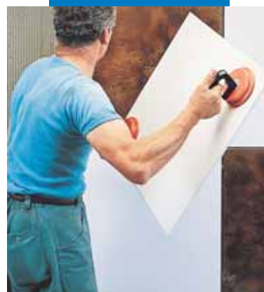
Polaganje KERAION-a na zid
