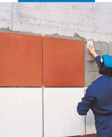
Polaganje velikoformatnih ploča s Kerabond+Isolastic
