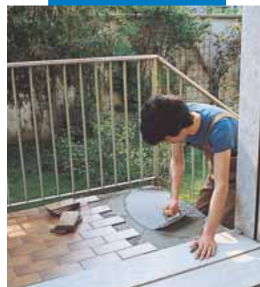
Vodonepropusno izravnavanje i polaganje s Kerabond+Isolastic
