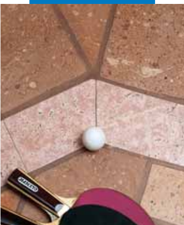
Pod od terakote poliran na licu mjesta, fugiran Keracolor-om GG pomiješanim s Fugolastic-om
