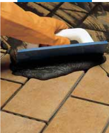
Fugiranje vanjskog poda od klinker pločica Keracolor-om GG pomiješanim s Fugolastic-om
