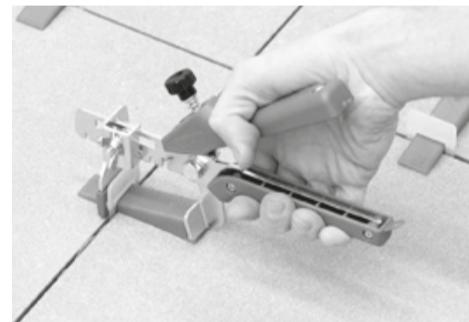
**2. KORAK** Umetnuti kajlu u otvor na bazi za niveliiranje, te klijevima za niveliiranje pločica stegnuti dok se gornji rubovi susjednih pločica u potpunosti ne izravnaju.
