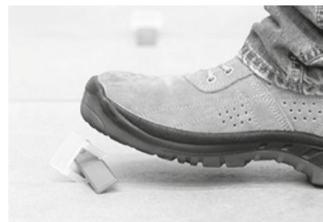
**3. KORAK** Nakon što se ljepilo u potpunosti stvrdne nogom ili gumenim čekićem ukloniti gornji dio baze za niveliiranje.
