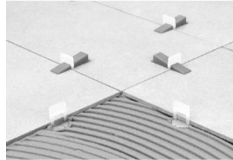
**1. KORAK** Nakon nanošenja ljepila na podlogu postaviti baze za niveliiranje ispod pločice, tako da se nalaze uzduž sve četiri strane pločice. Nakon toga postaviti susjednu pločicu.
