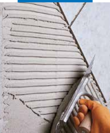
Polaganje jednom pečenih pločica na zidove s blokovima od plino betona
