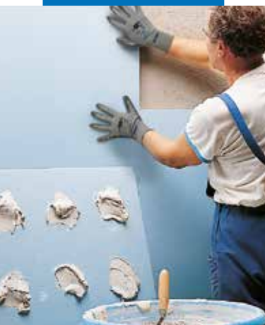
Polaganje ploča od polistiren pjene bijelim Keraflex-om
