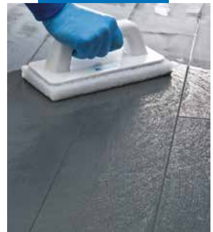
Čišćenje fuga Scotch-Brite® spužvom (kad je proizvod polutvrd)
