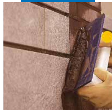
Nanošenje Ultracolor-a Plus na zid gumiranom gladilicom
