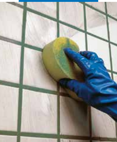
Čišćenje i završna obrada zidnih fuga celuloznom spužvom
