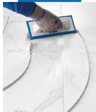
Nanošenje Ultracolor-a Plus na gresporculanske podne pločice s efektom mramora gumenom gladilicom
