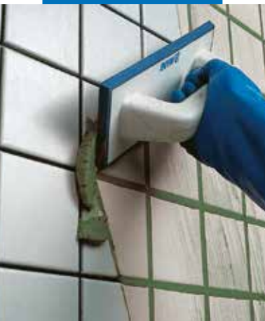
Nanošenje Ultracolor-a Plus na zid gumiranom gladilicom
