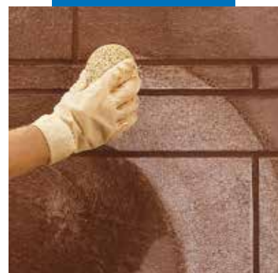
Čišćenje i završna obrada fuga spužvom
