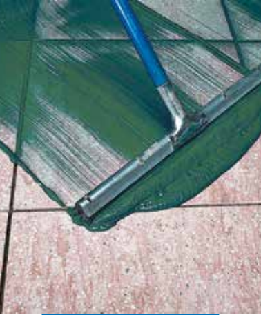
Nanošenje Ultracolor-a Plus na pod gumiranim brisačem
