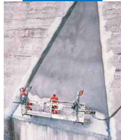
Primjer nanošenja Mapelastic-a špricanjem na branu
