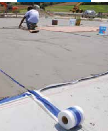
Hidroizolacija estriha Mapelastic-om i Mapeband-om
