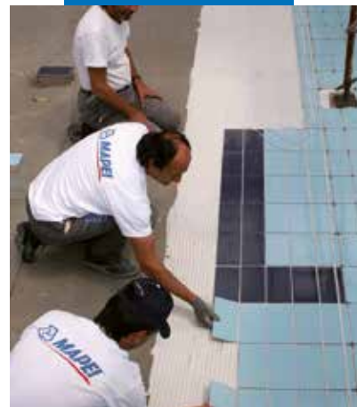
Polaganje keramičkih pločica na Mapelastic u bazenu
