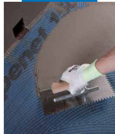
Nanošenje Mapelastic-a na Mapenet 150
