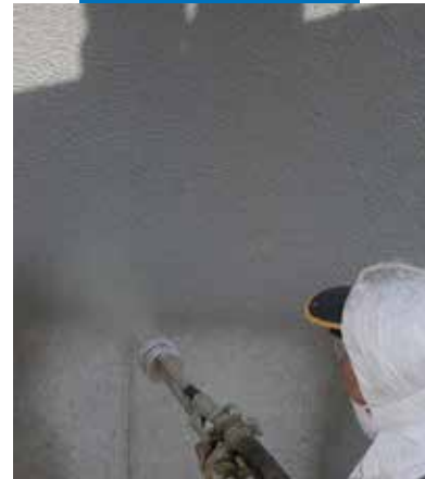
Primjer nanošenja Mapelastic-a špricanjem na vijadukt
