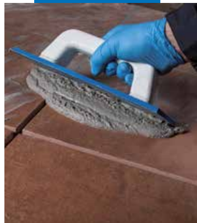
Fugiranje pločica Ultracolor-om Plus
