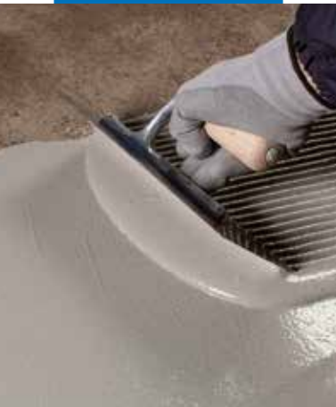
Nanošenje prvog sloja Mapelast ic -a Turbo
