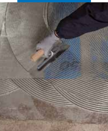
Polaganje Mapenet -a 150 u prvi svježi sloj Mapelast ic -a Turbo
