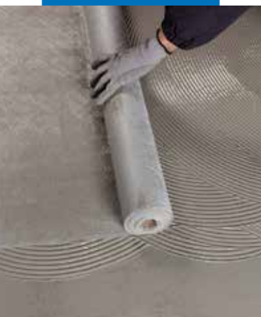
Polaganje Mapetex -a Sel u prvi svježi sloj Mapelast ic -a Turbo
