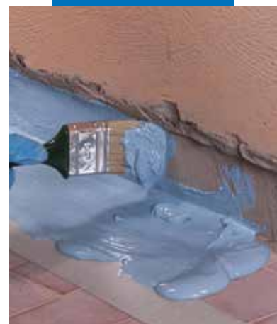
Nanošenje Mapelastic-a AquaDefense kistom na spoju pod-zid prije ugradnje Mapeband-a
