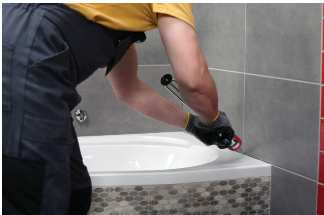
Spojevi sanitarnih uređaja sa oblogom ispunjeni su sanitarnim silikonom
