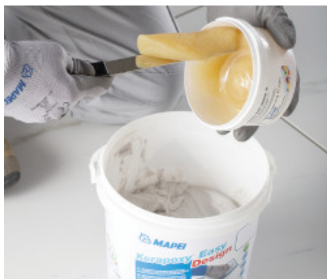
Istresite učvršćivač (komponenta B) u posudu u kojoj je komponenta A
