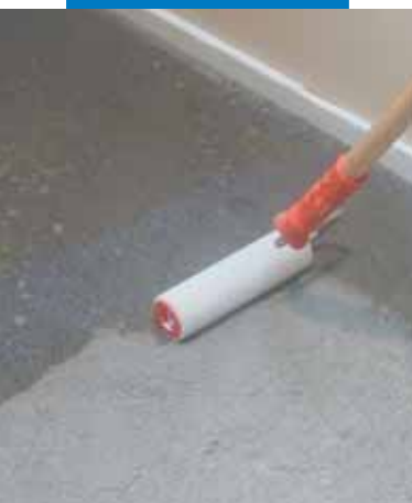
Nanošenje Primer-a G valjkom
