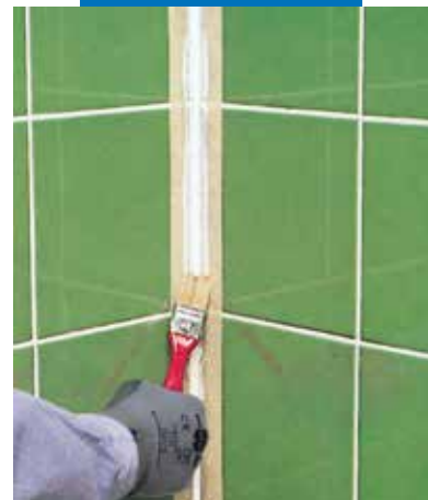
Zaglađivanje dilatacije sapunicom i kistom
