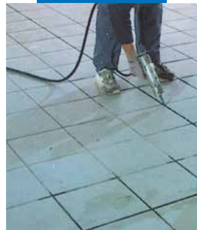
Brtvljenje keramičkog opločenja Mapesil-om AC
