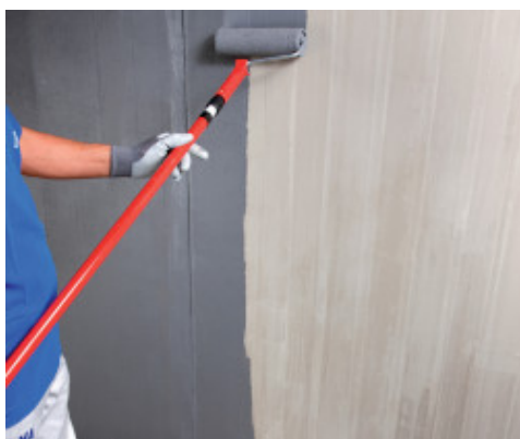
Nanošenje Eco Prim Grip Plus na beton pomoću valjka
