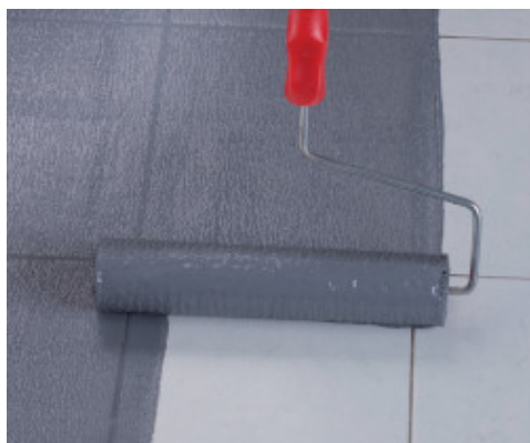
Nanošenje Eco Prim Grip Plus valjkom na postojeće porculanske pločice
