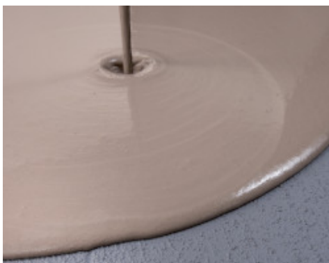
Primjena samo-nivelirajuće mase na suhom Eco Prim Grip Plus-u na starom podu
