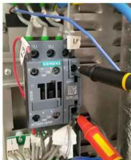
b- Prekinite ulazno napajanje energijom uređaja i provjerite postoji li deformacija ili gubitak kontakta na fazama i neutralnim kabelima otpornika koji ne provodi struju.
