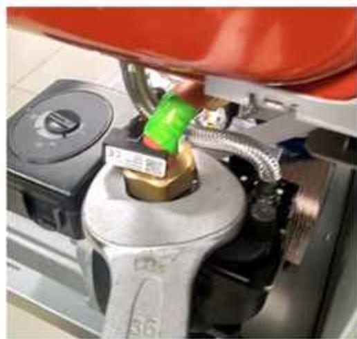
Otvor za zrak pumpe se može ukloniti kopčom.
